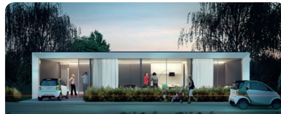
Ansicht des E-Lab vom Bruckmannweg – die Fassade an der Westseite besteht aus einem speziell entwickelten Vakuumglas, das sehr gute Wärmedämmwerte mit hoher Transparenz verbindet.
